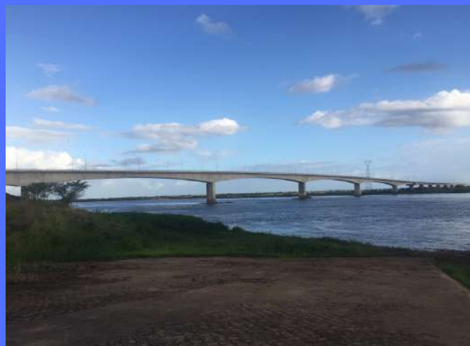
Veduta del ponte Guebuza sul fiume Zambesi. Foto/Martina Bolognesi
