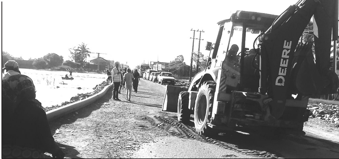
Após obras, a N1 está reaberta a circulação normal em Xai-Xai
